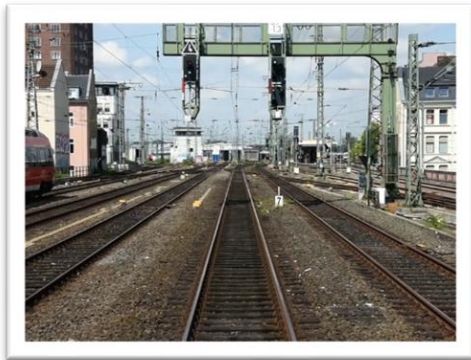
Ausfahrt Köln Hbf Richtung Köln-West und Start des PA1. Im Hintergrund ICE-Werk und rechts die S-Bahn-Station Hansaring. Foto: DB AG
