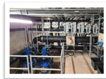
Badewassertechnik, Umwälzpumpen
