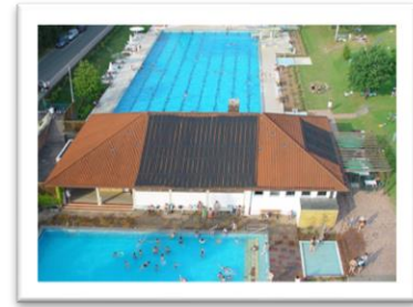
Luftaufnahme des Freibads vor den Sanierungsmaßnahmen
