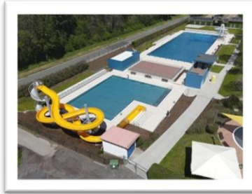
Luftaufnahme des neuen Freibads mit neuer Großwasserrutsche
